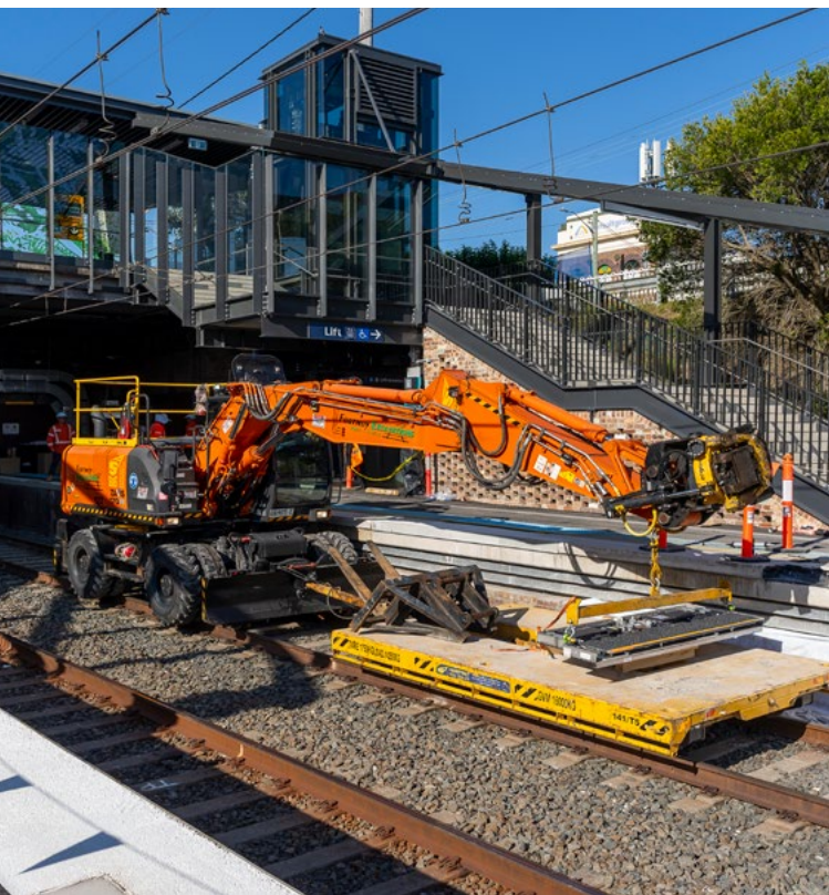
Επάνω: Εργασίες μετατροπής του Μετρό του Σίδνεϊ στο Hurlstone Park
