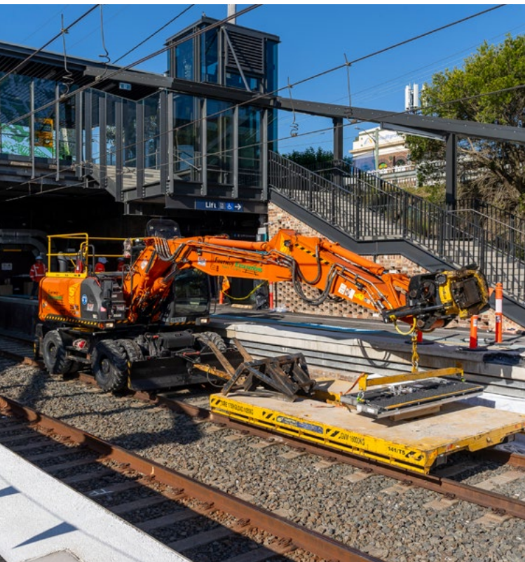
Trên: Các công trình chuyển đổi của Sydney Metro tại Hurlstone Park
