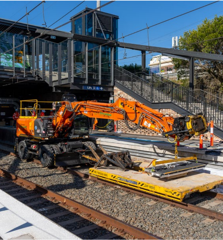
الصورة أعلاه: أعمال تحويل مترو سيدني في هرلستون بارك
