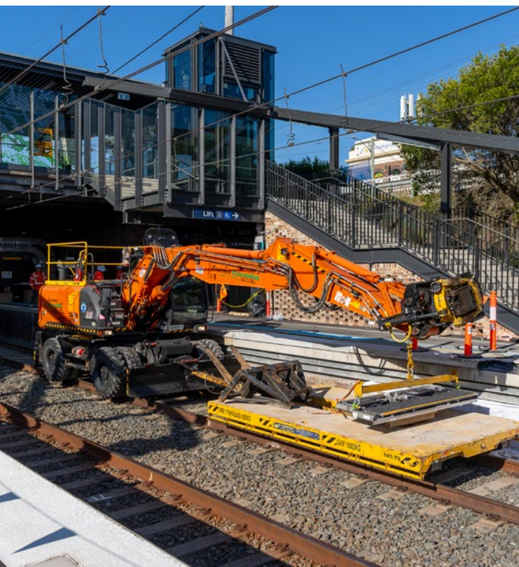
上图：位于Hurlstone Park的悉尼地铁改造施工现场
